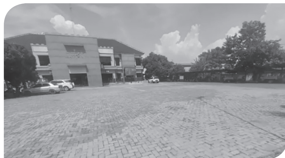
Gedung kantor Kecamatan Rajeg Kabupaten Tangerang.
